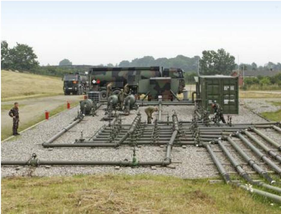
Feldtanklager sind logistische Einrichtungen für die Bevorratung von Kraftstoffen in operativ relevanter Größenordnung. Im Rahmen der Kraftstoffversorgung werden durch die Bundeswehr zentrale Fähigkeiten für Lagerung, Distribution, Nachweis, Transport und die Qualitätssicherung von Flug- und Bodenkraftstoff sichergestellt.
